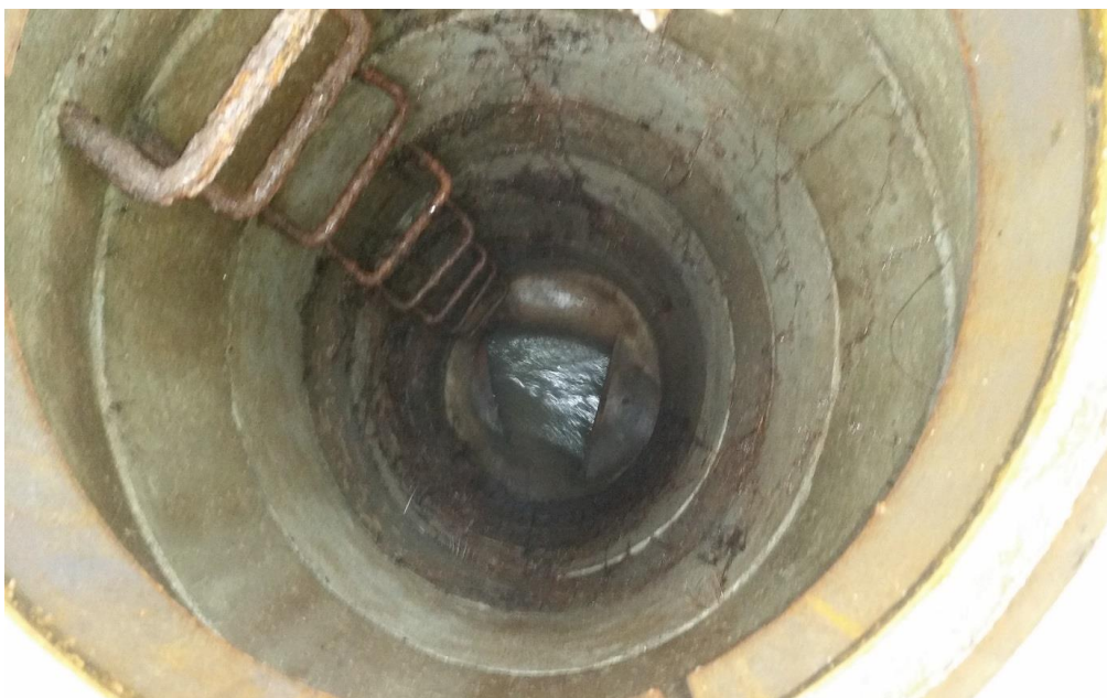
Før rehabilitering av kum
