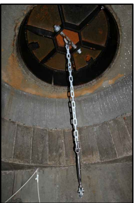
Bilde: Sikring av kumlokk
