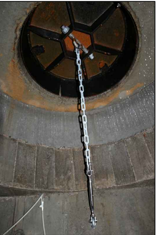
Bilde: Sikring av kumlokk
