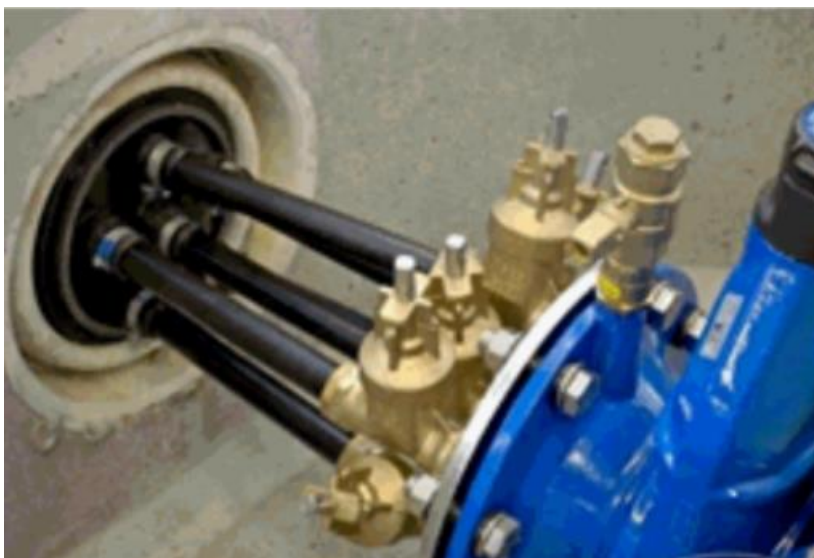
Figur 9. Eksempel på stikkledninger som ligger buntet sammen
