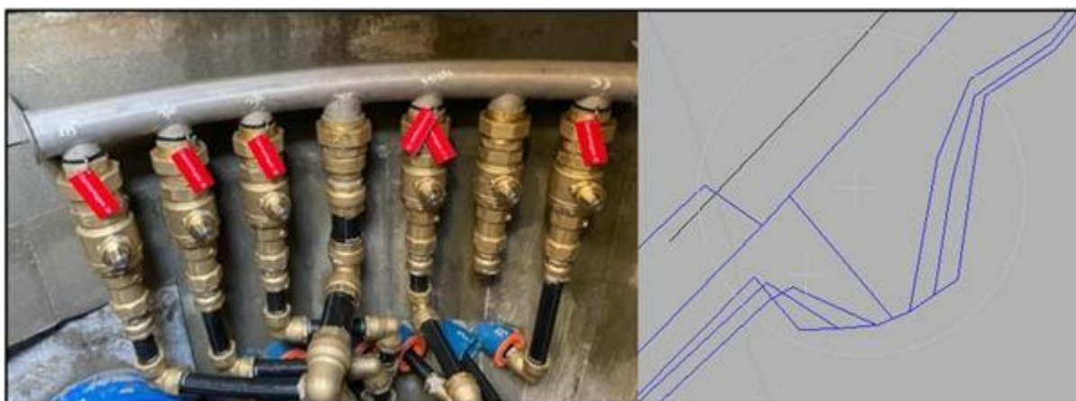
Figur 8. Innmåling av stikkledninger gjennom manifold.
